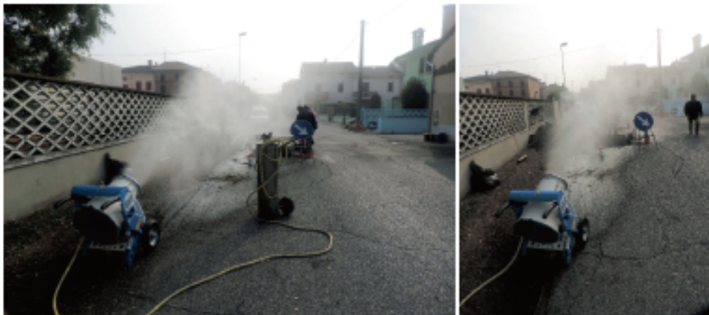
Figura 5 - Cannone nebulizzatore nell'area d'intervento.
